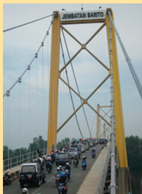
(ii) Jembatan Barito
